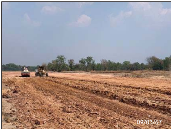
กิจกรรม Clearing และ Grubbing
