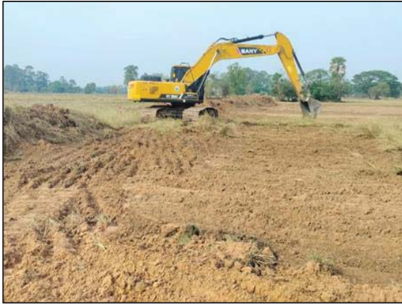
กิจกรรม Clearing และ Grubbing
