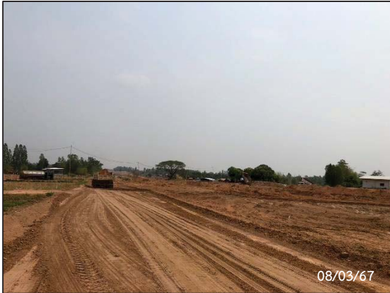
กิจกรรม Clearing และ Grubbing
