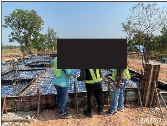
กิจกรรมงานผูกเหล็กพื้น ชั้นที่ 1 Staff House Building Type 03
