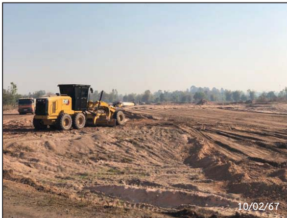
กิจกรรม Clearing และ Grubbing
