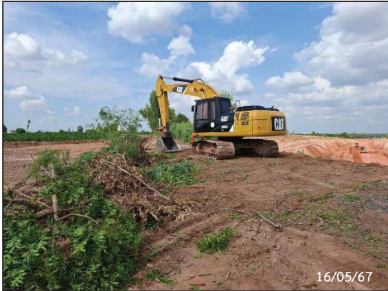
กิจกรรม Clearing และ Grubbing
