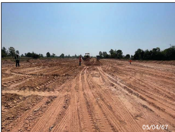
กิจกรรม Clearing และ Grubbing
