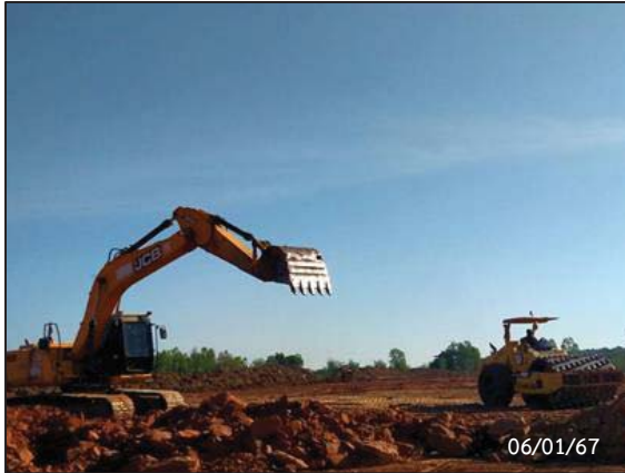
กิจกรรม Clearing และ Grubbing
