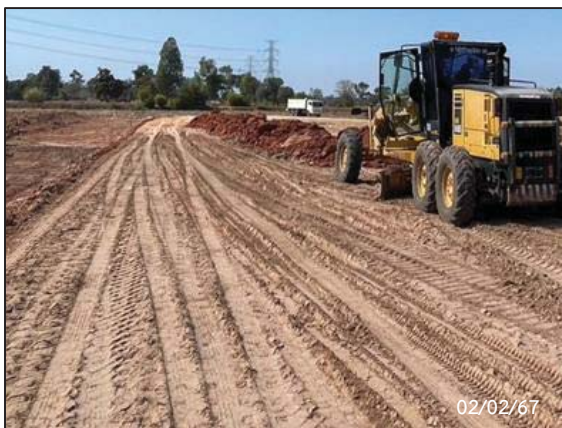
กิจกรรม Clearing และ Grubbing
