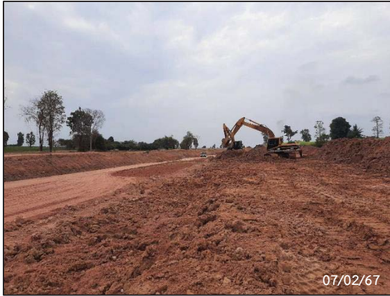
กิจกรรม Clearing และ Grubbing
