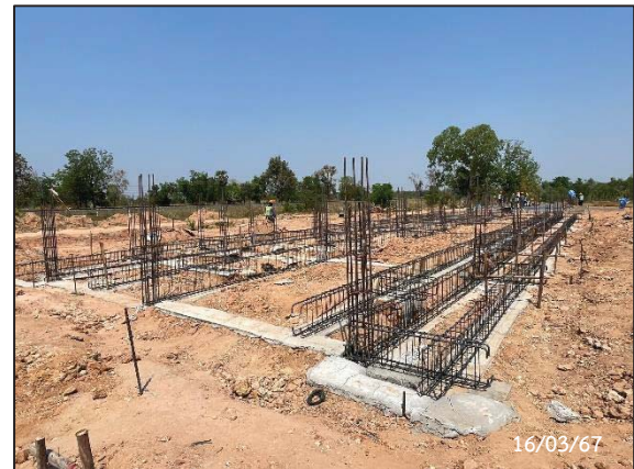
กิจกรรมงานผูกเหล็กคานคอดิน Staff House Building Type 04
