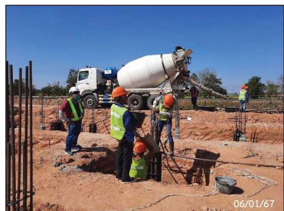
กิจกรรมเทคอนกรีตเสาต่อม่ออาคาร Staff House Building
