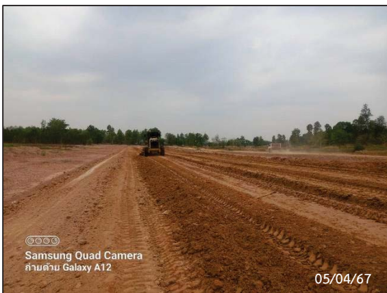
กิจกรรม Clearing และ Grubbing
