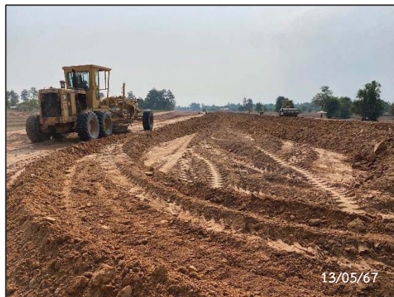
กิจกรรม Clearing และ Grubbing
