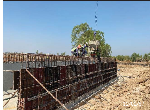
กิจกรรมเทคอนกรีตผนัง Box Underpass
