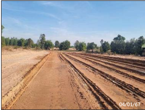
กิจกรรม Clearing และ Grubbing
